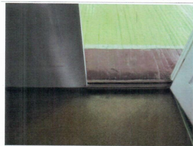
Фото №18 – Пути движения внутри здания (двери)
