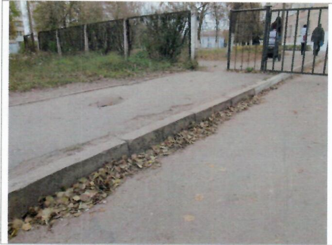
Фото №3 – Подходы к объекту
