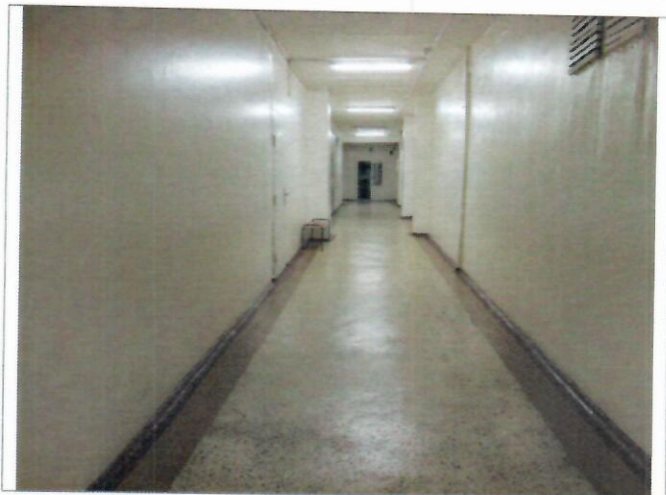
Фото №13 – Пути движения внутри здания (коридор)
