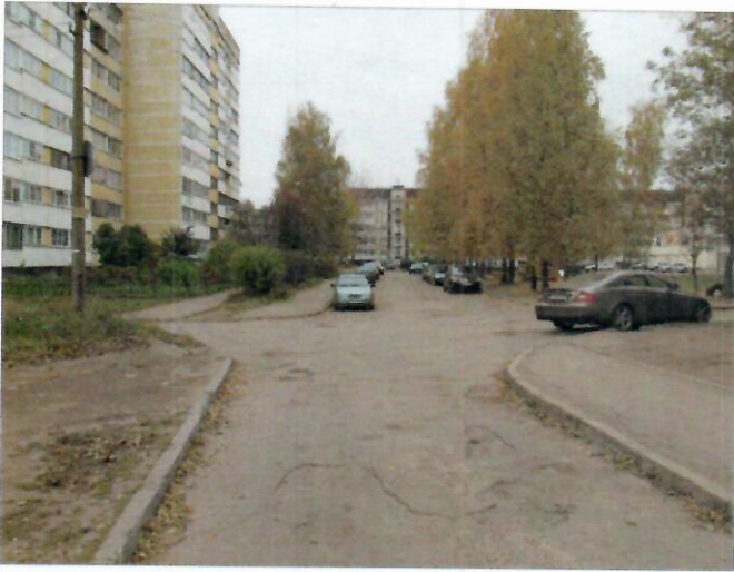
Фото №1 – Подходы к объекту
