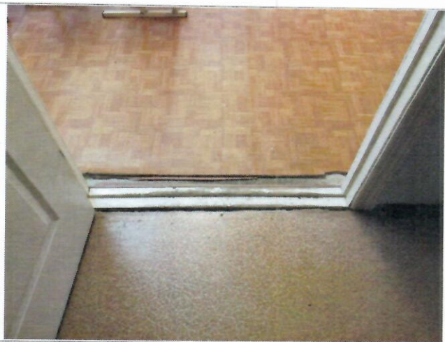
Фото №19 – Пути движения внутри здания (двери)
