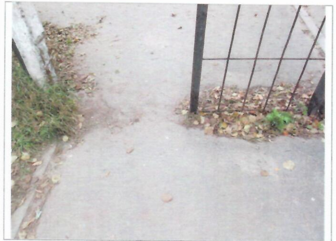
Фото №4 – Вход на прилегающую территорию
