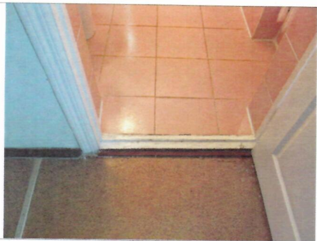
Фото №20 - Пути движения внутри здания (двери)
