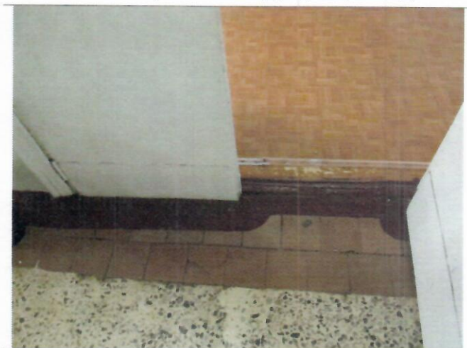
Фото №17 – Пути движения внутри здания (двери)
