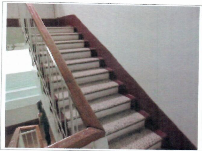
Фото №14 – Пути движения внутри здания (лестницы)
