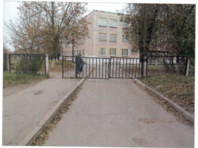
Фото №2 – Подходы к объекту
