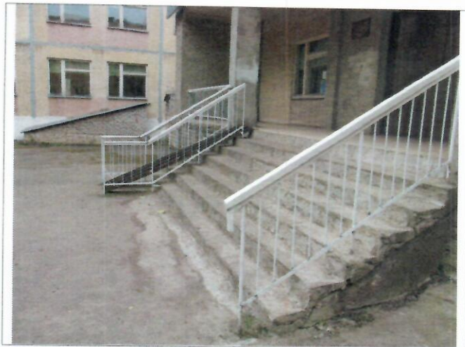
Фото №7 – Наружная лестница
