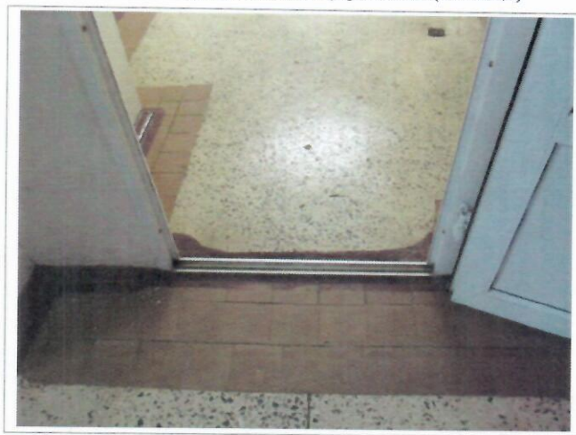
Фото №16 – Пути движения внутри здания (двери)
