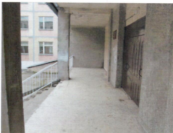
Фото №9 – Входная площадка главного входа
