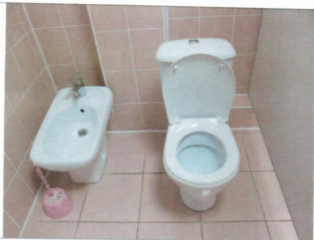
Фото №32 – Санитарно-гигиеническое помещение (туалетная кабина)
